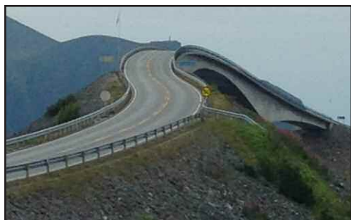
Pont de Storseisundet, gran construcció noruega
