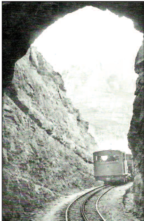
Tunel de l'Àngel, foradat a base de barrinades
