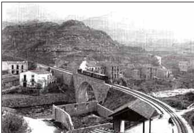
Baixador La Bauma i el pont de la riera de Marà
